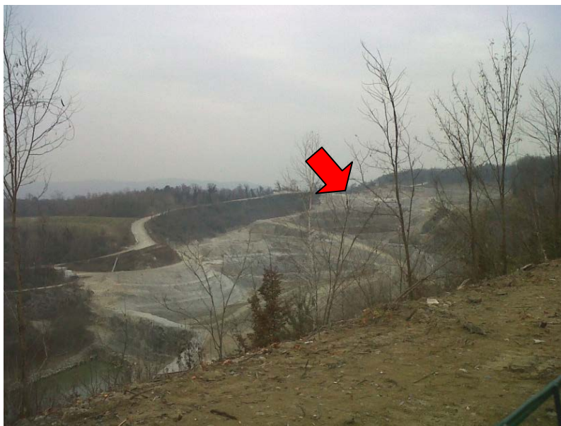
Figura 4 – La cava dal ricettore R1, la freccia evidenzia la posizione (approssimativa) della volata
